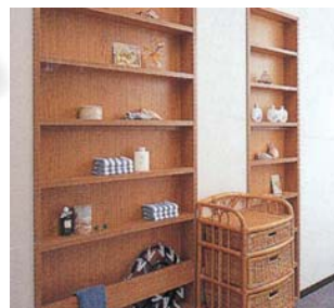
▼柱間利用 外張り工法により、従来デッドスペースだった柱の間を有効に活用できます。
